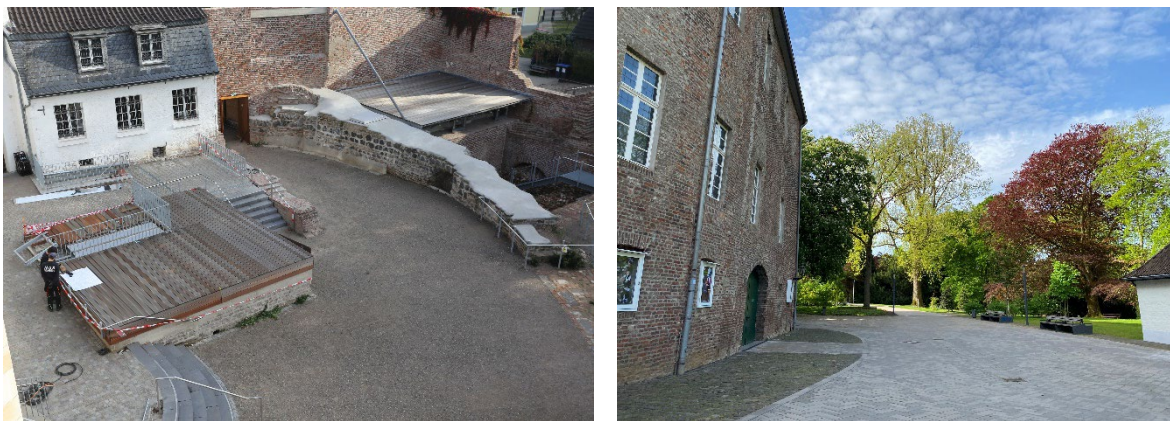
Abbildung 11: Schlossinnenhof im Umbau und neuer Platz westlich des Schlosses
